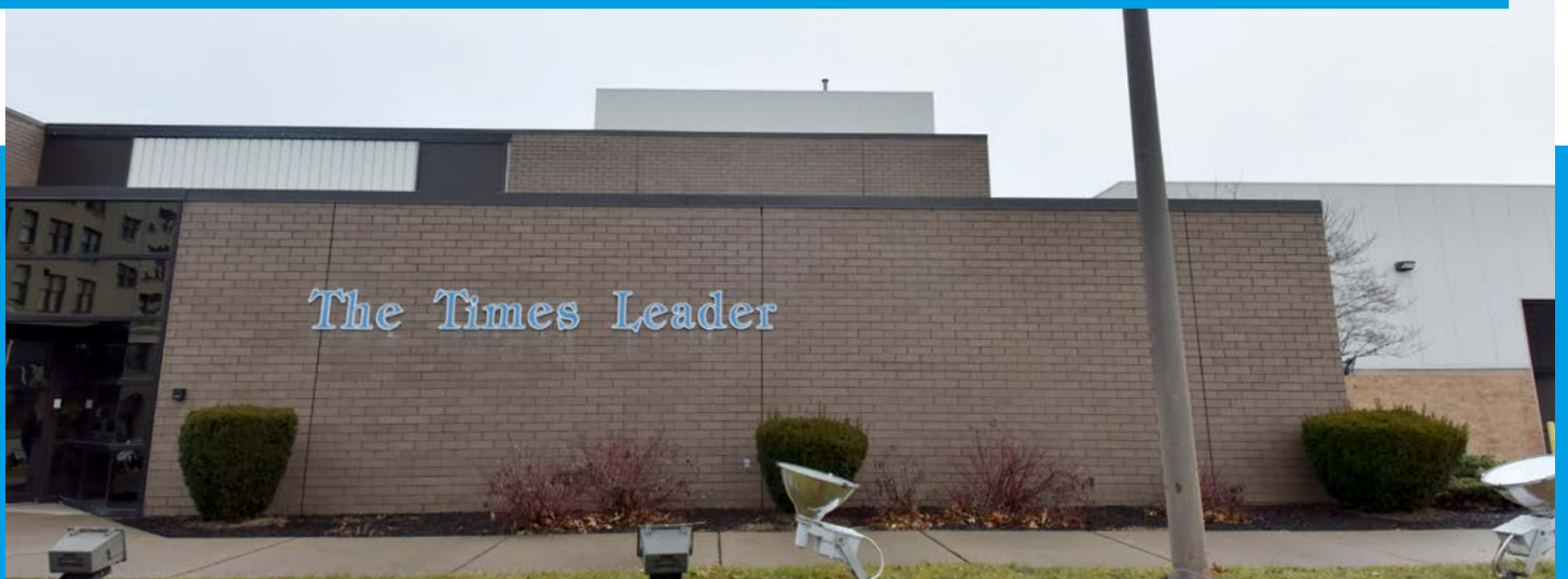
Civitas传媒在宾夕法尼亚州维尔克斯 巴里的建筑
